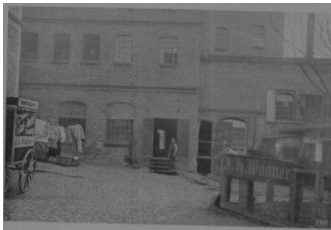
Teilansicht Färbereigebäude linke Ecke Wohnhaus mit Lieferwagen, Hauptgebäude
